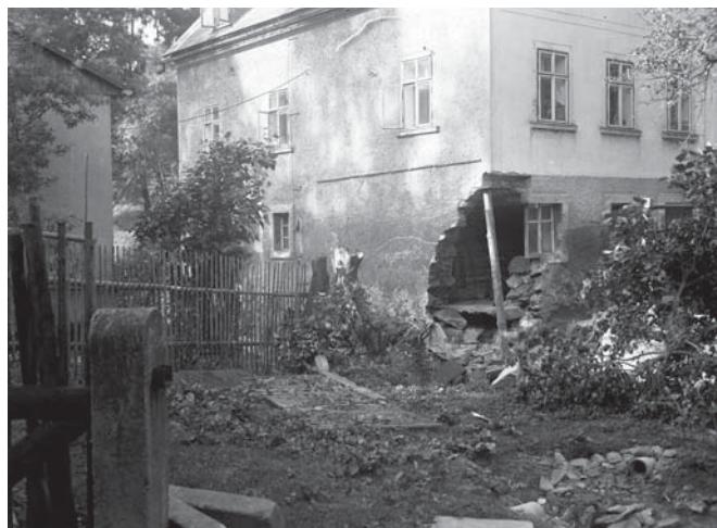
Následky povodně v roce 1957
