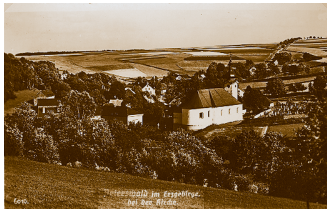
Pohled na kostel se hřbitovem
