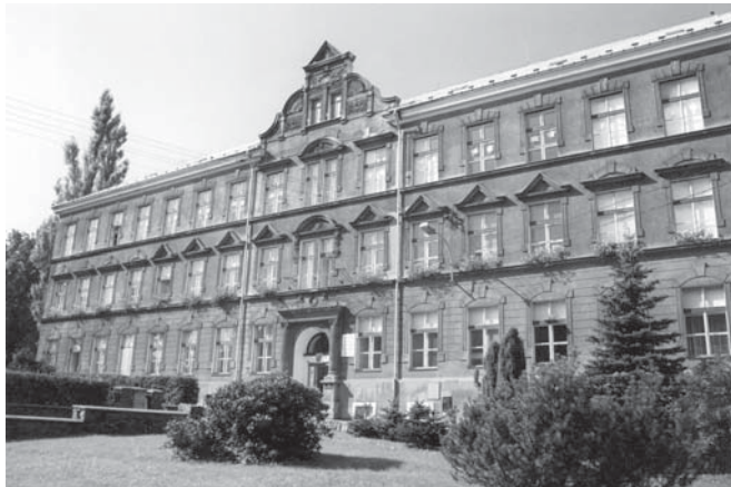
Nová budova školy v současnosti
